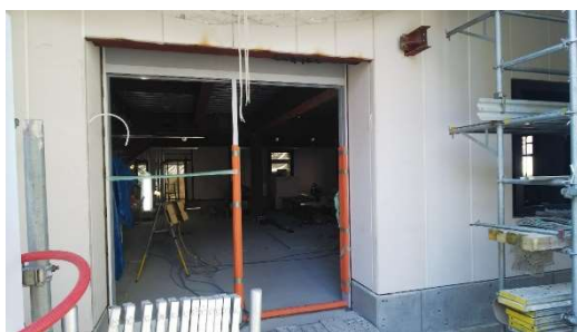
1F エントランス付近
